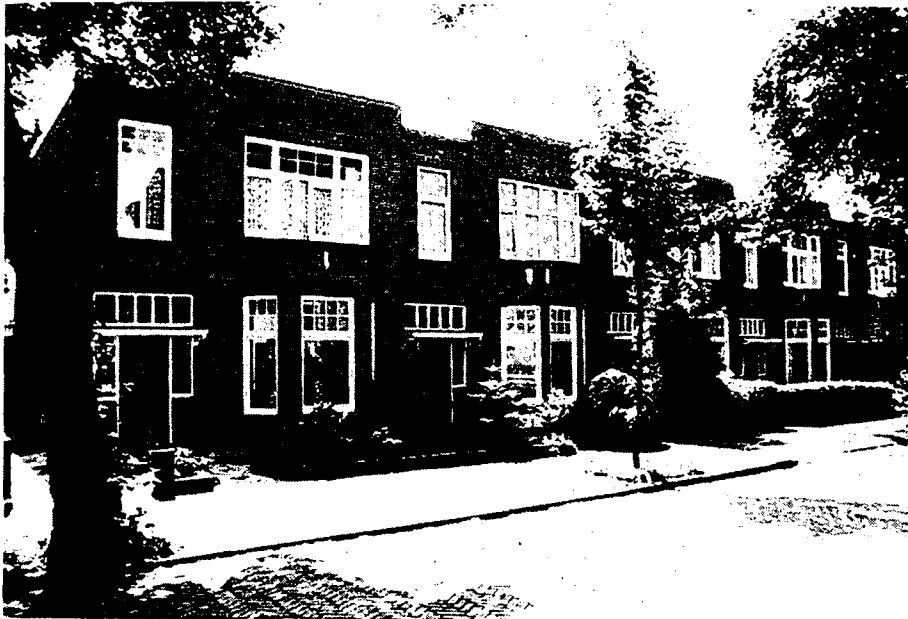
Complex woningen aan de Leeuwerikstraat uit 1918.
