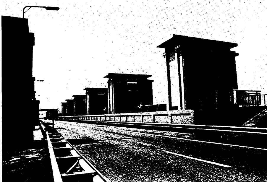
Lorentzsluizen in de Afsluitdijk, gebouwd in 1932 naar ontwerp van het Bureau Zuiderzeewerken en Ir. D. Rosenberg architect-adviseur.
