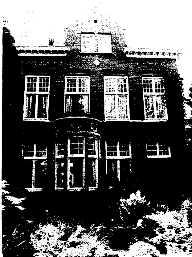
Monumentaal woonhuis aan de Stationsstraat, in 1907 gebouwd naar ontwerp van de Sneker architect G. Stapenséa.
