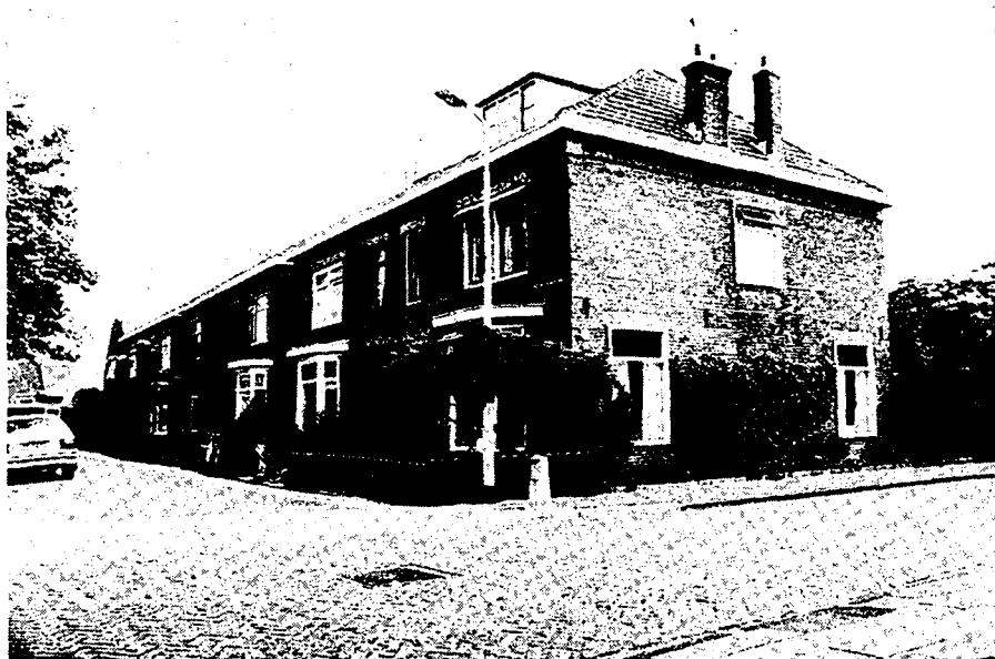
Drietal dubbele middenstandswoningen uit de jaren '20 aan het Hid Hero-plantsoen.
