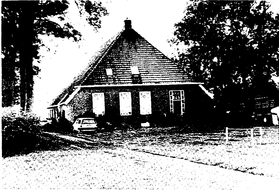
Doraweg nr. 3, meest gave voorbeeld van de omstreeks 1905 gebouwde stelpboerderijen in de polder De Kikkert.
