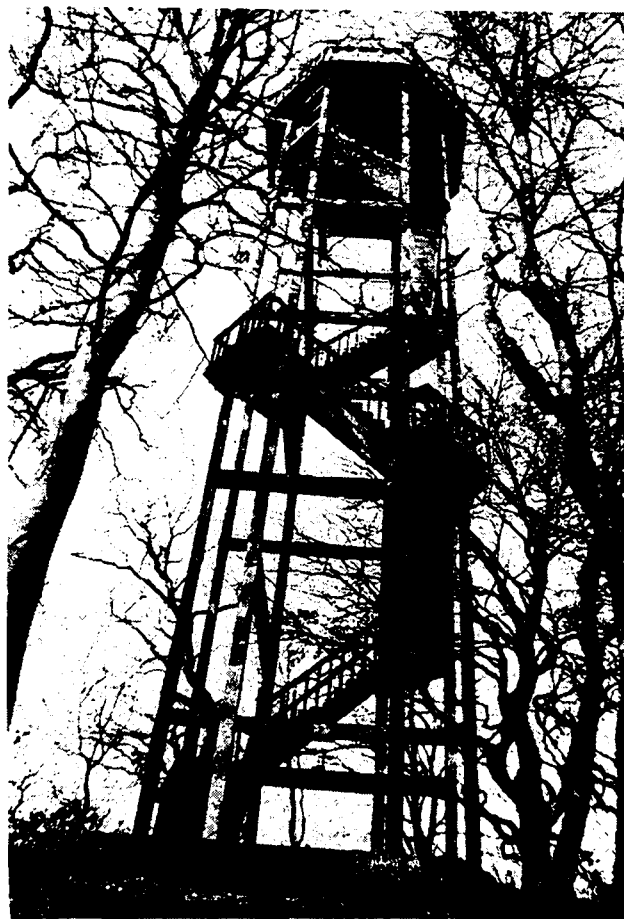
De belvédère (1924) op de berg van Brongerga, een voorbeeld van vroege betonbouw, recentelijk geheel gerenoveerd. De betonnen belvédère, ontworpen en vervaardigd door de Heerenveense firma Boltje en Buwalda was de opvolger van een in 1917 gebouwde houten uitkijktoren.
